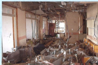
2011.4.1 請戸小学校 1階廊下
