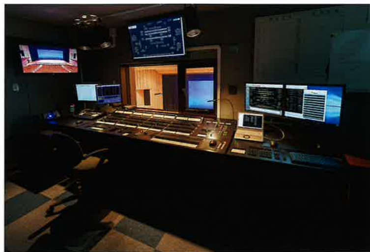
大ホール調光室内の記憶調光操作卓「パコリスシュート」
