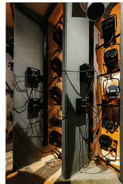
LEDとハロゲンを組み合わせた構成のフロントサイドスポットライト
